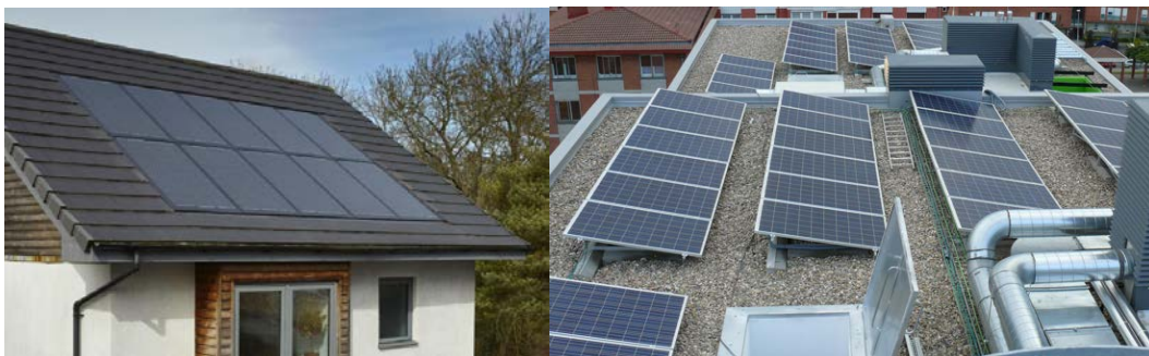
Figura 8. Paneles integrados en cubierta (Izquierda, fuente: internet Solarweb) y colocados en una cubierta plana (derecha, fuente propia)
